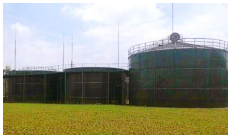
四川新迪医药污水处理项目
