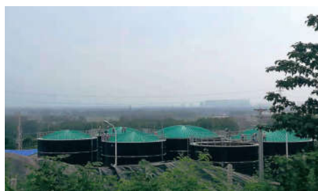
安徽淮南市垃圾渗滤液处理项目
